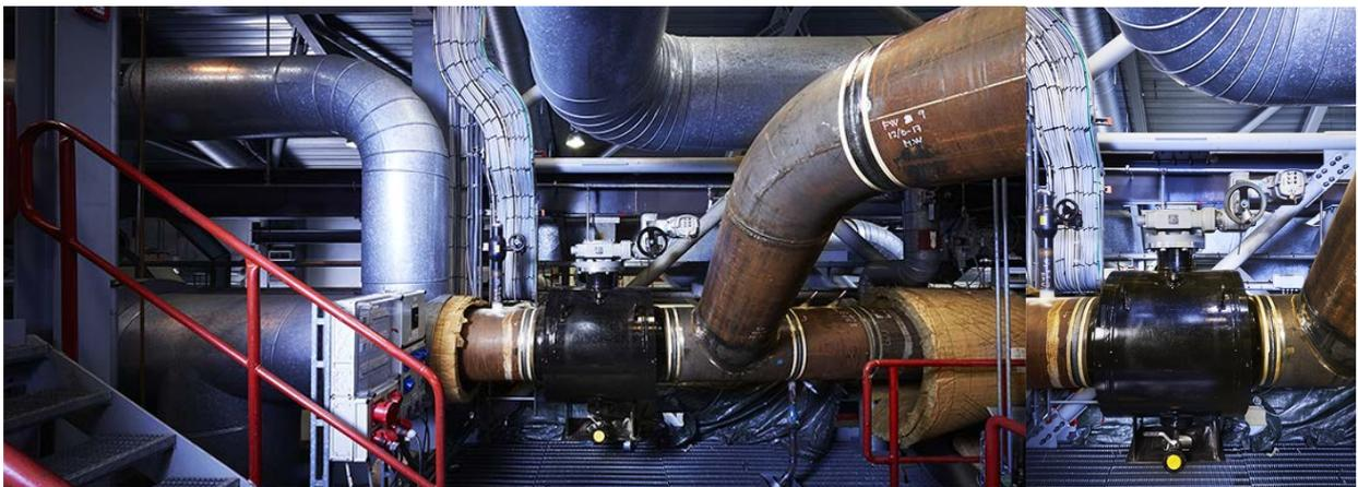
BROEN BALLOMAX – robinet à double palier avec une sphère arbrée, double block and bleed DBB et une vidange dans le corps du robinet.
